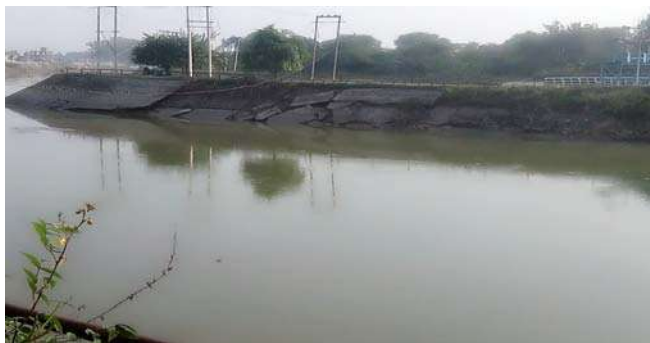
Fig.3 Damage due eddies
